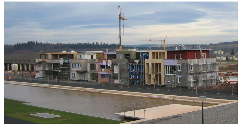
Baustand an der Wasserkante, im Februar 2004
