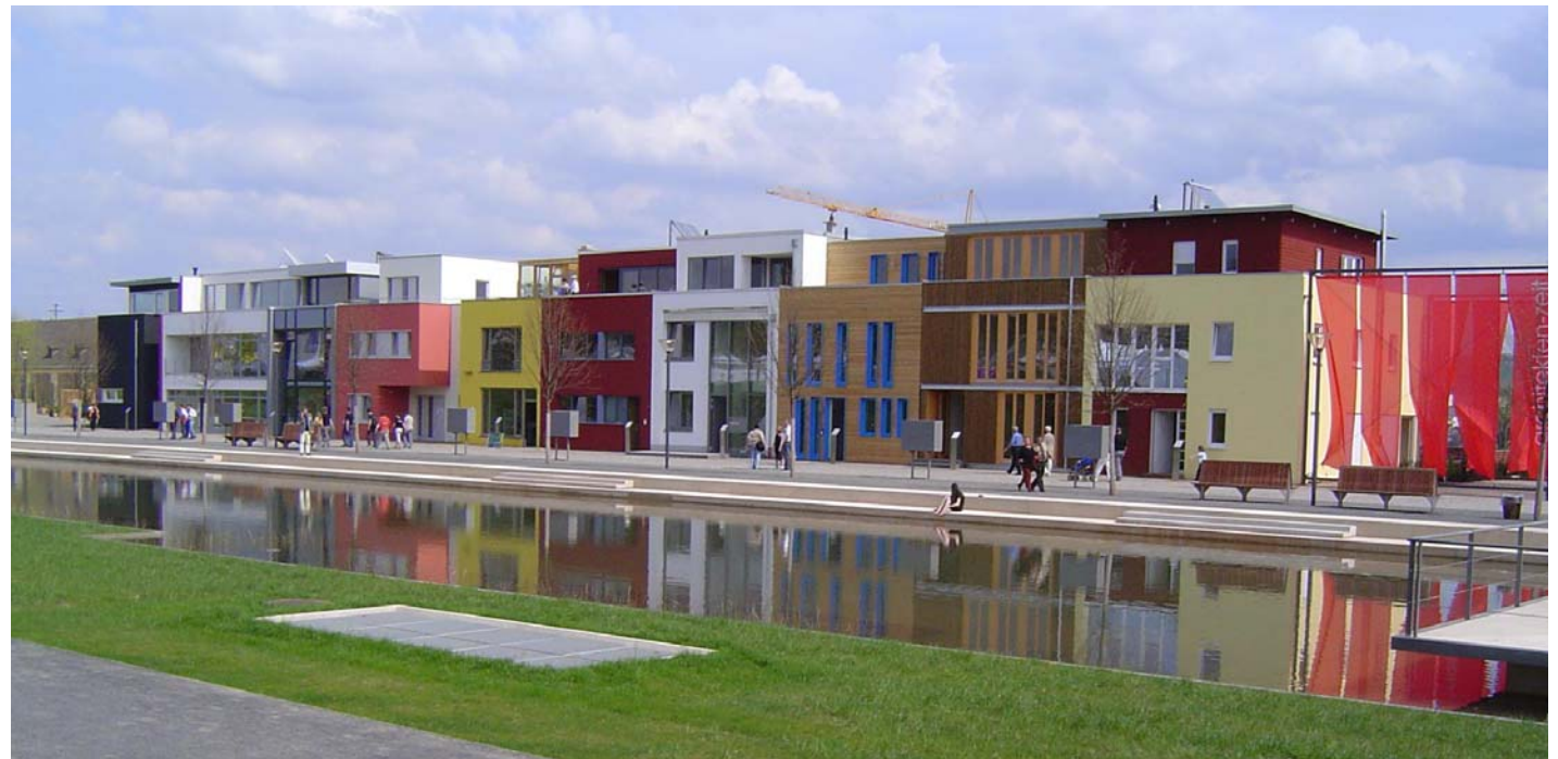
1. Bauabschnitt „Wohnen an der Wasserkante“ während der Bauausstellung im Sommer 2004
