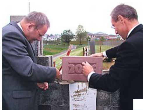
Bürgermeister Bernarding (rechts) und Baudezernent Dietze setzen den Grundstein für das "Haus der Vereine".
