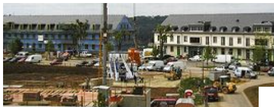
Blick von der Dachterrasse des WIP-Centers auf die Baustelle für die ersten Bürovillen im Wissenschaftspark.
